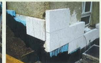
Isolation et assainissement du pied d'une façade.
