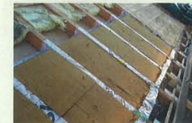
Rénovation énergétique d'une toiture.
